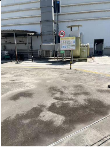
初期雨水收集池
