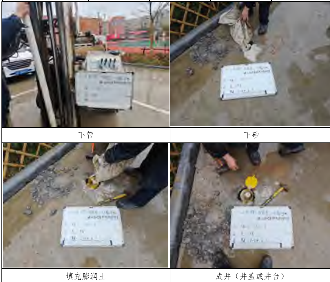
图 5.2-5 现场建井照片
