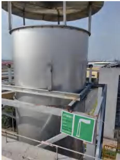
图 3-7 印刷、复合、固化废气处理设施排气筒
