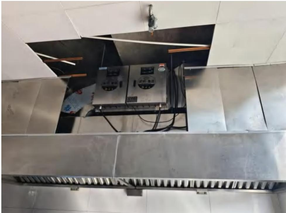
图 3-4 食堂油烟废气处理设施现场照片
